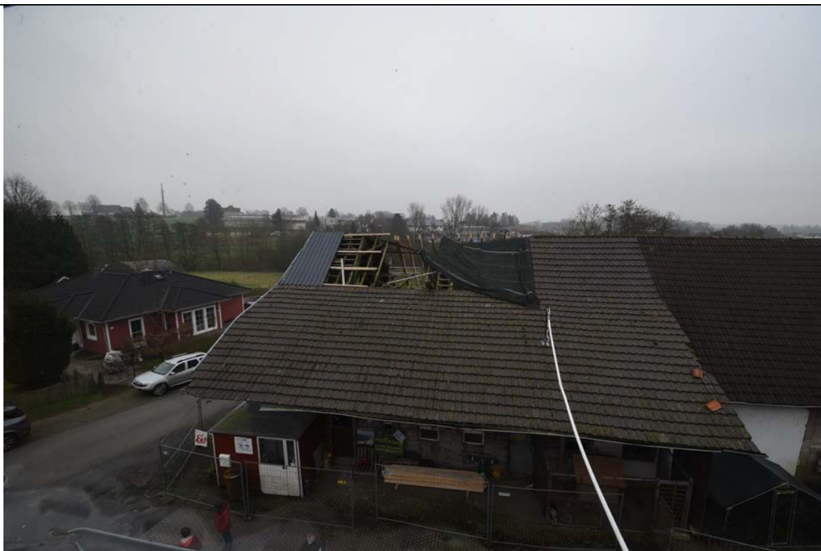
Bild 11 Blick aus dem Wohnhaus auf das gegenüberliegende Wirtschaftsgebäude mit stark geschädigtem Dach und einsturzgefährdetem Dachstuhl
