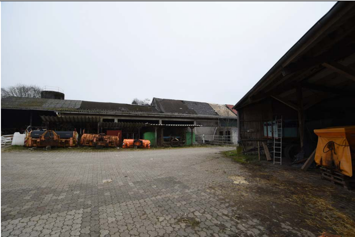
Bild 33 Blick vom Maschinenschuppen auf die Wirtschaftsgebäude mit abgestellter Technik auf der befestigten Fläche
