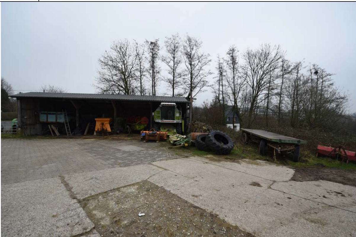
Bild 12 Maschinenschuppen an der Grundstücksgrenze 99 zur Kuhlener Straße
