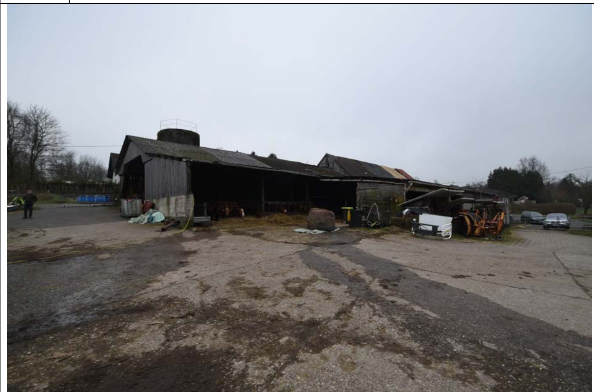
Bild 30 Blick auf die südöstliche Seite der Wirtschaftsgebäude
