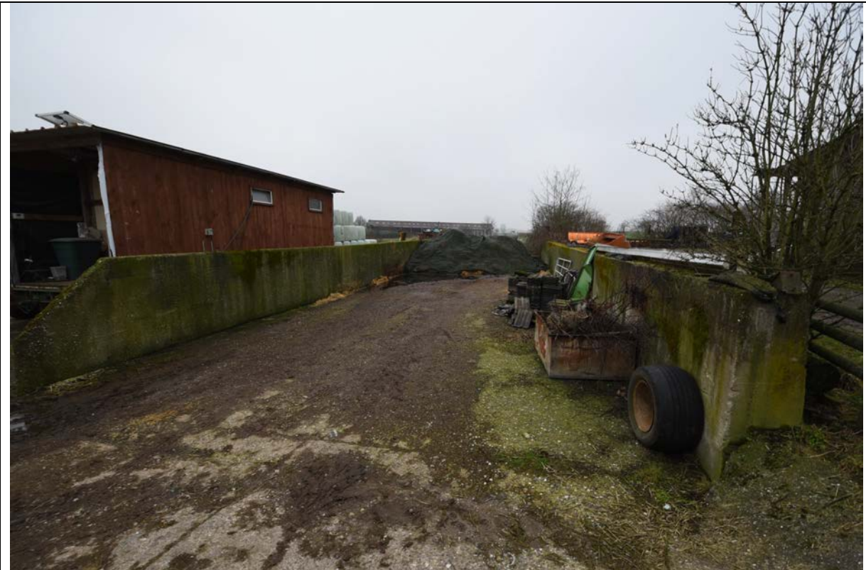
Bild 27 Blick auf die Fahrsiloanlage
