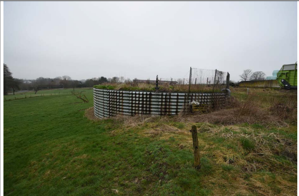
Bild 35 Metallrundsilo zur Güllelagerung
