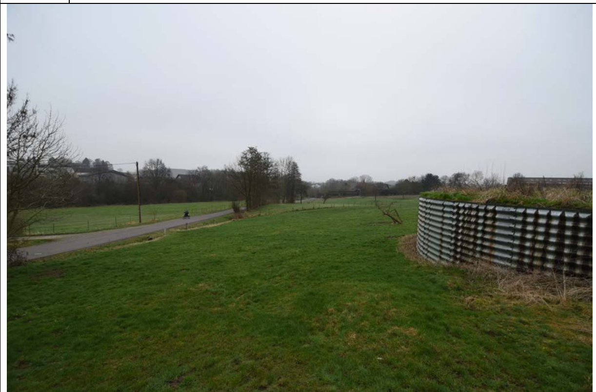
Bild 36 Blick entlang des Güllerundsilos auf die Kuhlener Straße und Grundstück 99
