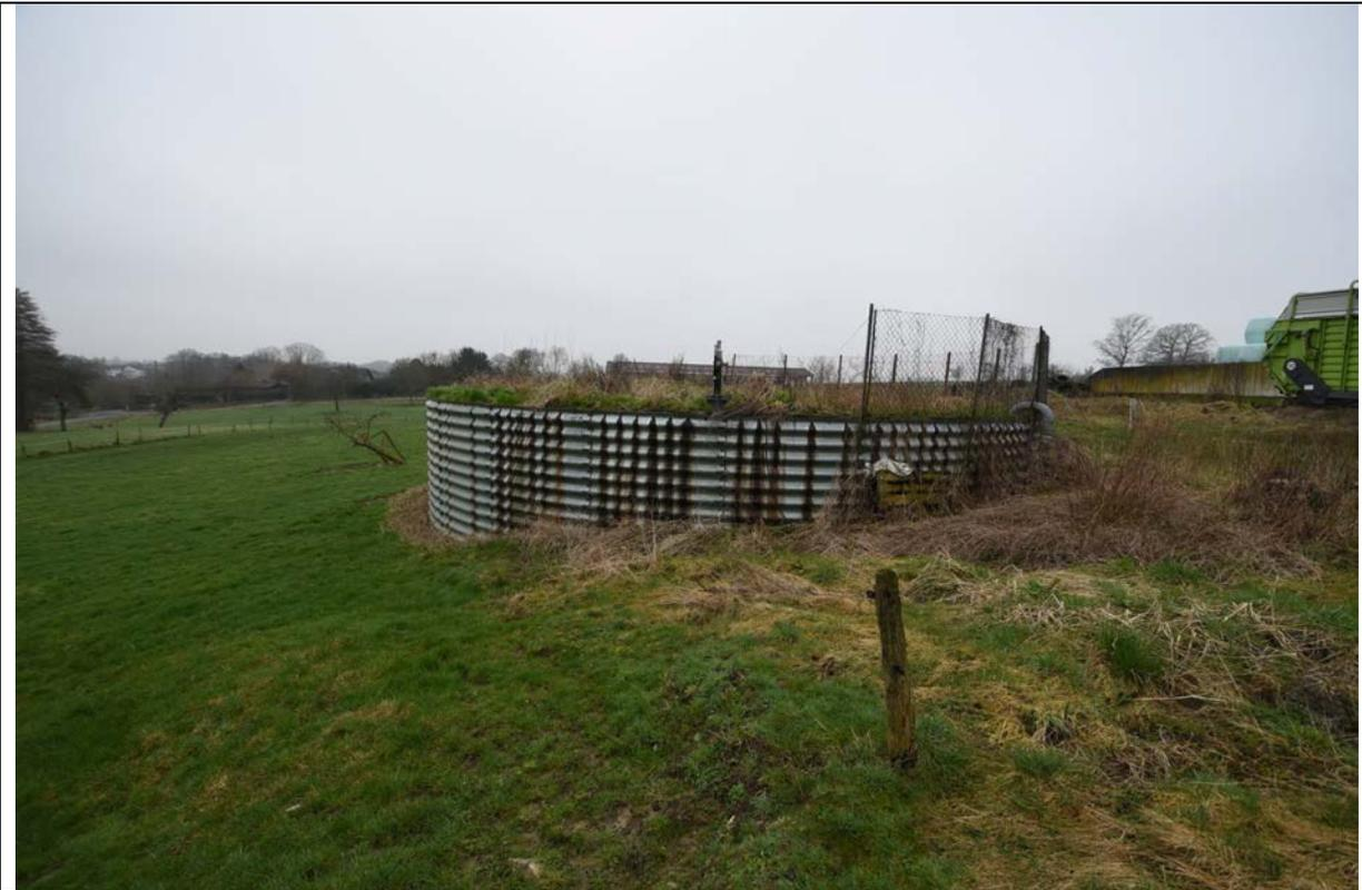
Bild 35 Metallrundsilo zur Güllelagerung
