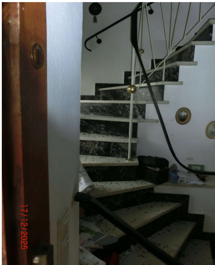
KG und Treppe zum DG
