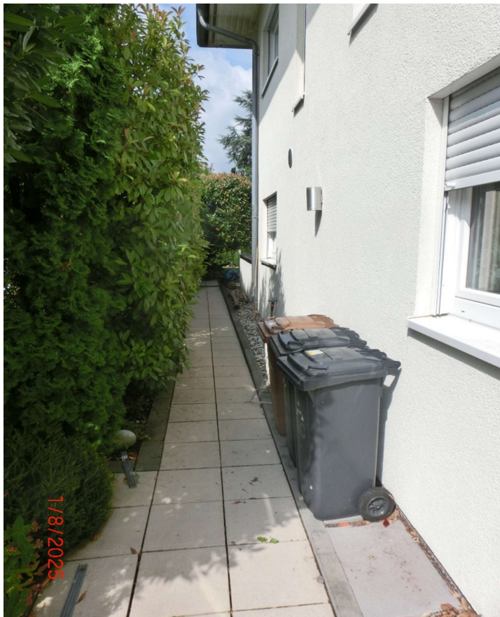
Garage und straßenseitige Vorderansicht
