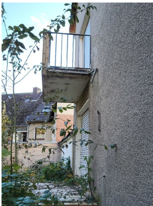
Rückseite mit Balkon und Terrasse
