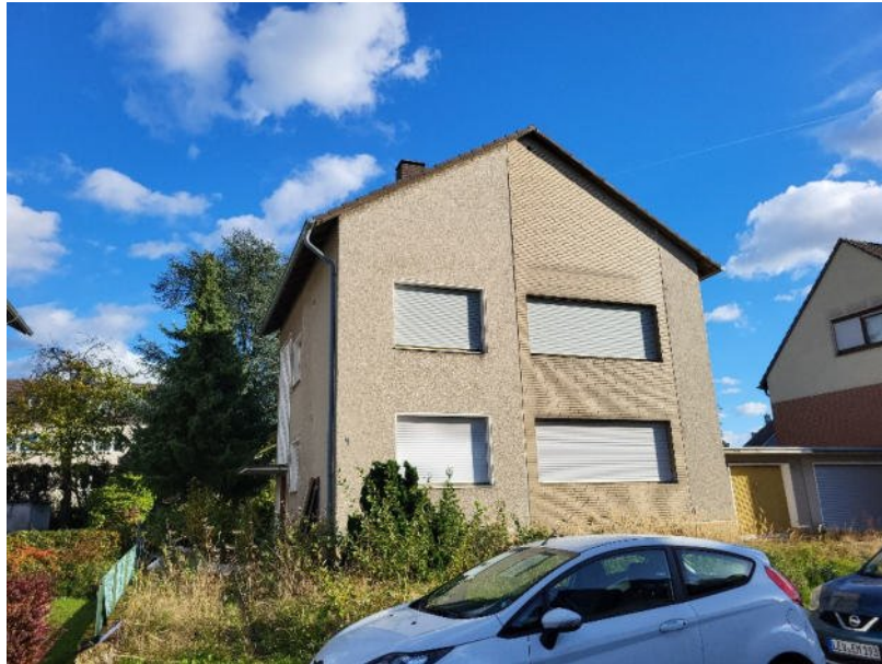
Ansicht Straßenseite (Westen)
