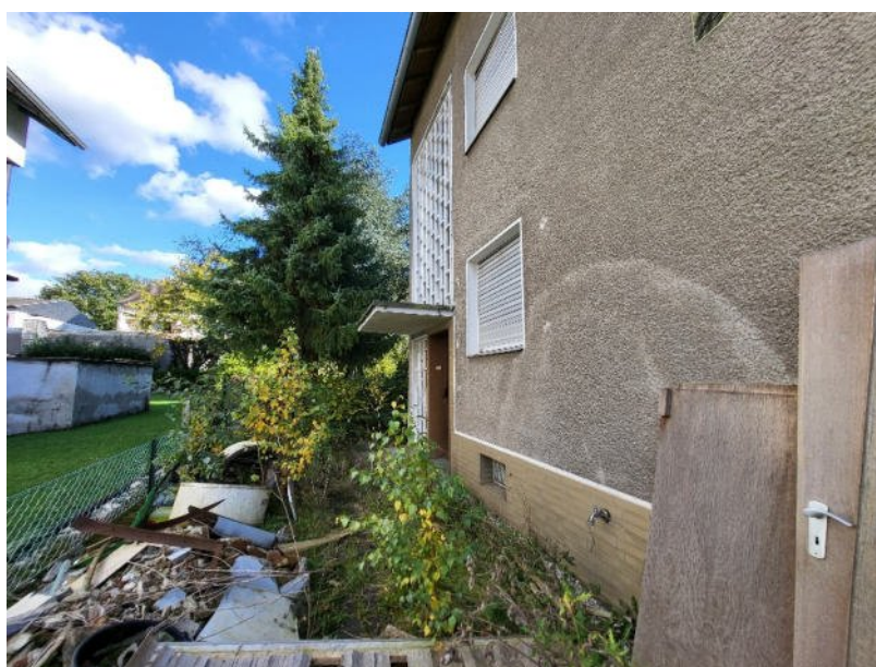
Hauseingang mit Bauschutt
