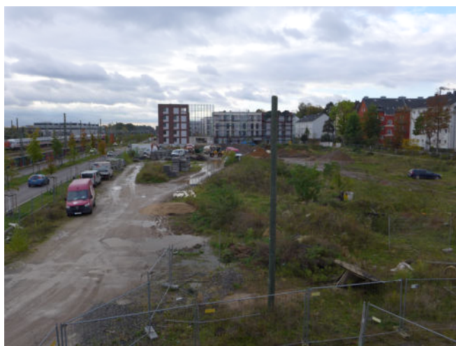
Blick von der Campusbrücke
