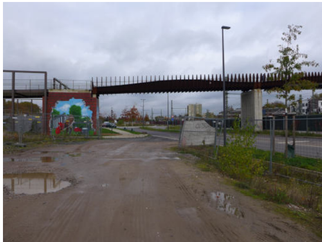
Blick Richtung Norden (Campusbrücke)
