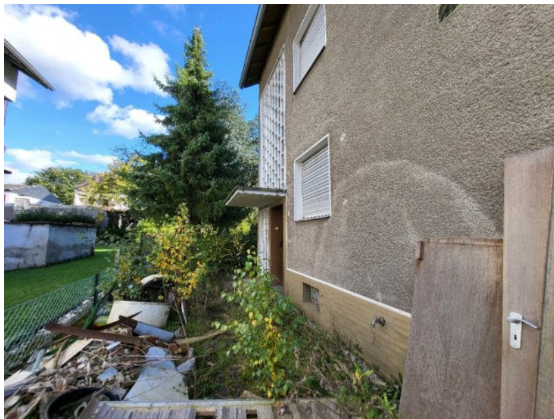
Hauseingang mit Bauschutt
