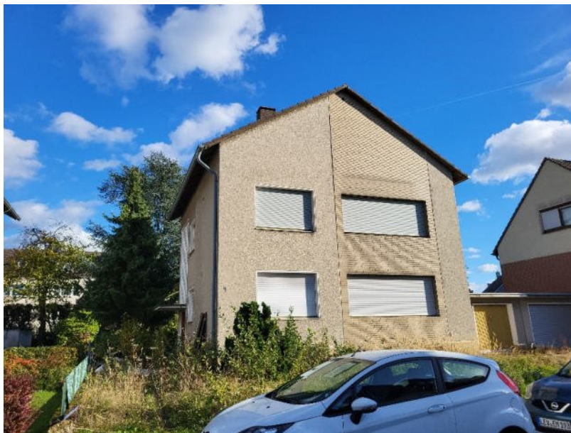
Ansicht Straßenseite (Westen)
