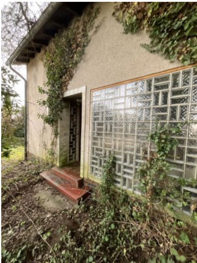
4) Hauseingang Haus Nr. 31
