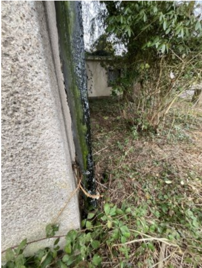
7) Fallrohr schadhaft
