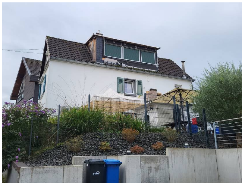
Nordseite mit Anbau
