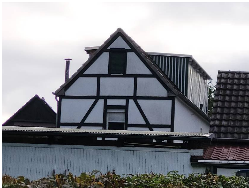
Westseite (von der Wuppertalstraße) mit Fachwerk (verm. nur optisch)
