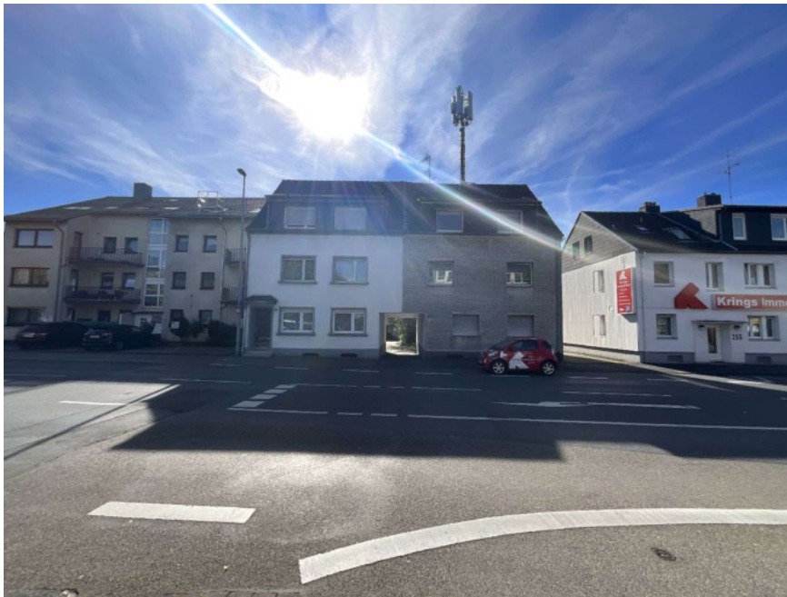
1) Nordansicht / Quettinger Straße
