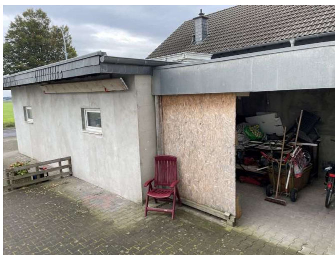
Pkw-Garage mit Anbau
