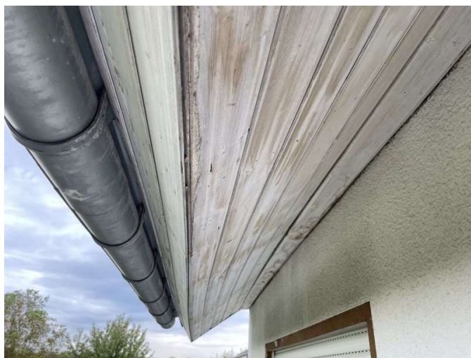
Instandsetzungsbedürftiger Dachüberstand
