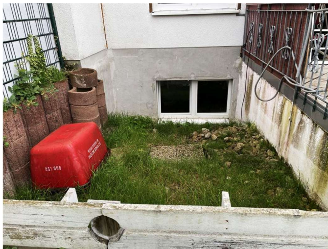
Hinterer Lichtschacht vor Kellergeschossausbau
