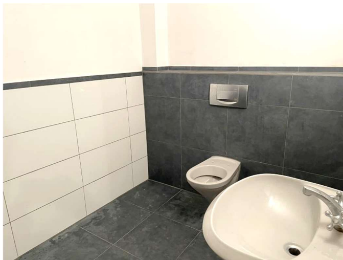
Bad im Kellergeschossausbau
