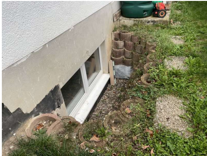
Seitlicher Lichtschacht vor Kellergeschossausbau
