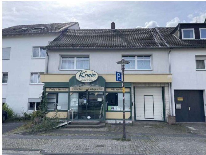
Wohn- und Geschäftshaus Marktstraße 16
