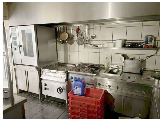
Küche im EG des Wohn- und Geschäftshauses
