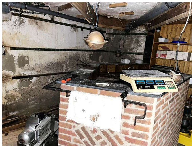
Kellerraum in der Teilunterkellerung des Nebengebäudes
