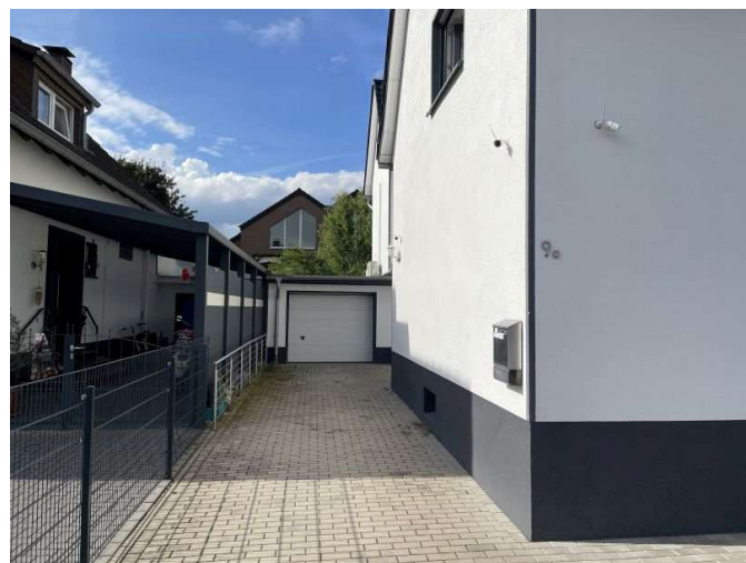
Zuwegung zum Hauseingang 9 a
