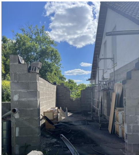
Ansicht Garage nicht fertiggestellt
