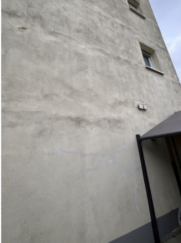
5) Giebelfassade Hinterhaus Westansicht
