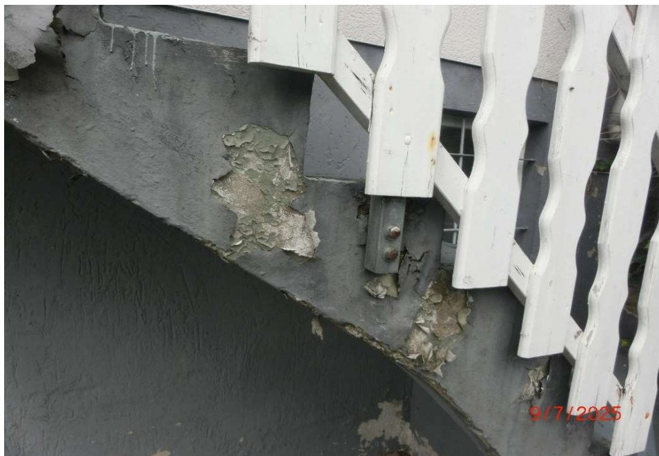
Dienstbarkeitsweg und Gartentreppe
