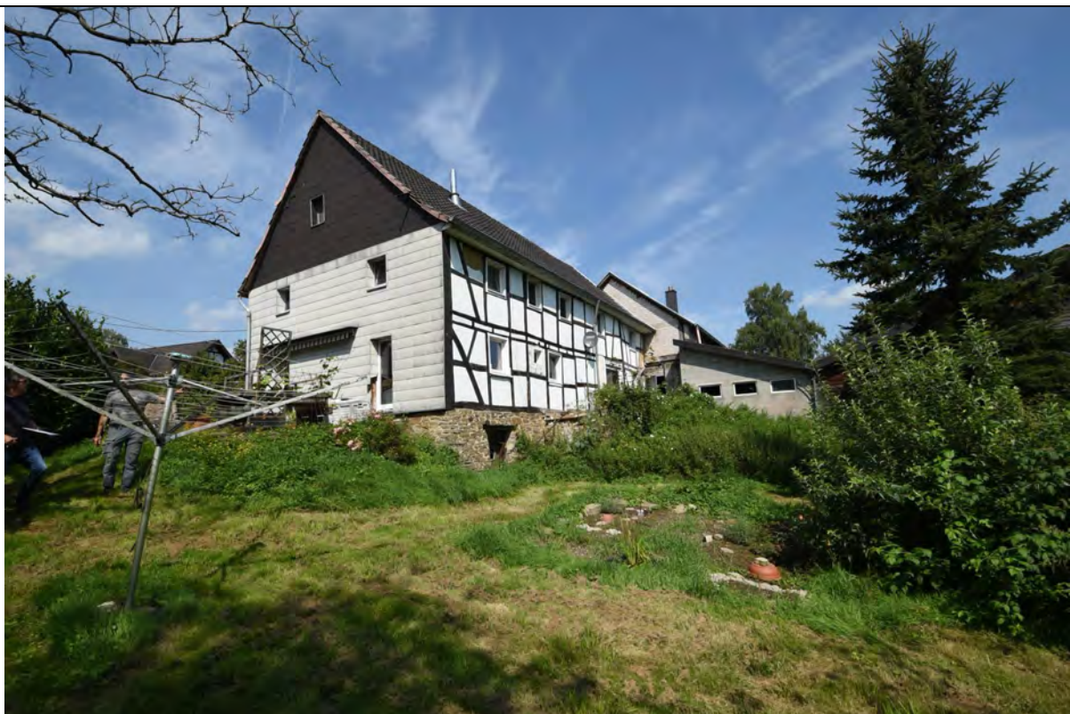
Bild 3 Rückseite des Wohnhauses mit Giebel Richtung Süden
