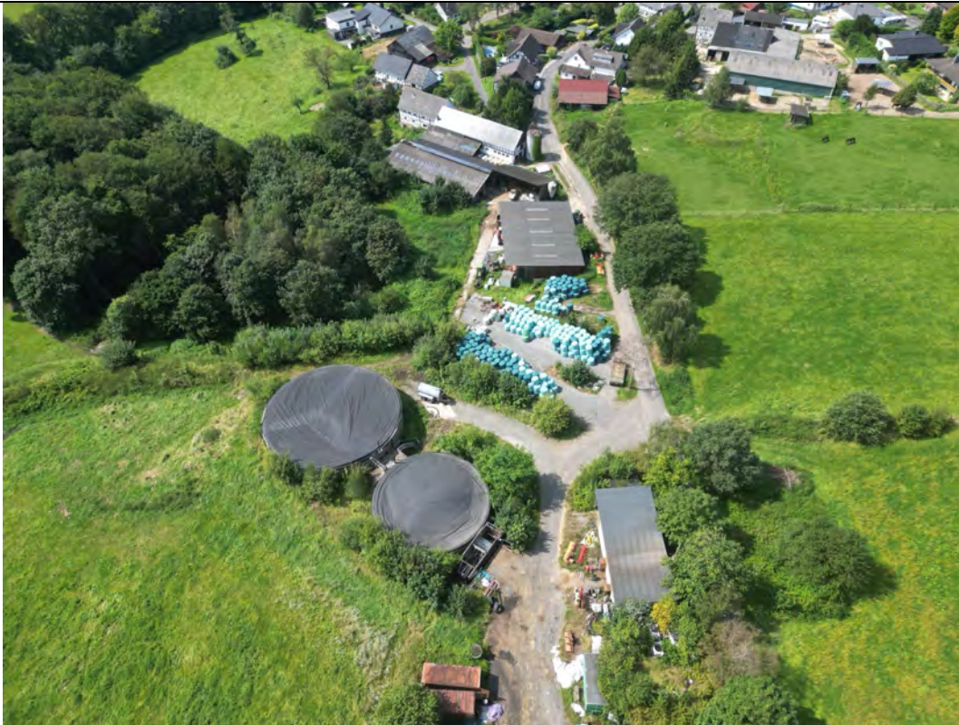
Bild 4 Blick über die Hofstelle mit der Biogasanlage am unteren Bildrand
