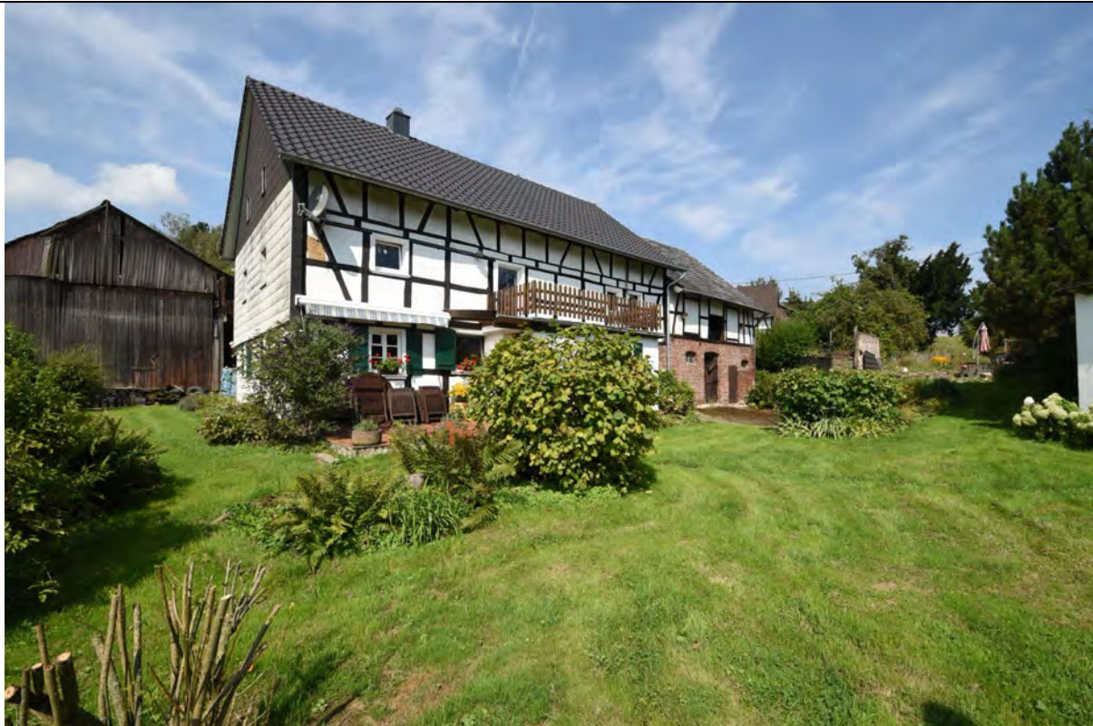
Bild 2 Rückseite Altenteilerhaus Flurstück 147 mit Giebel links des Scheunengebäudes
