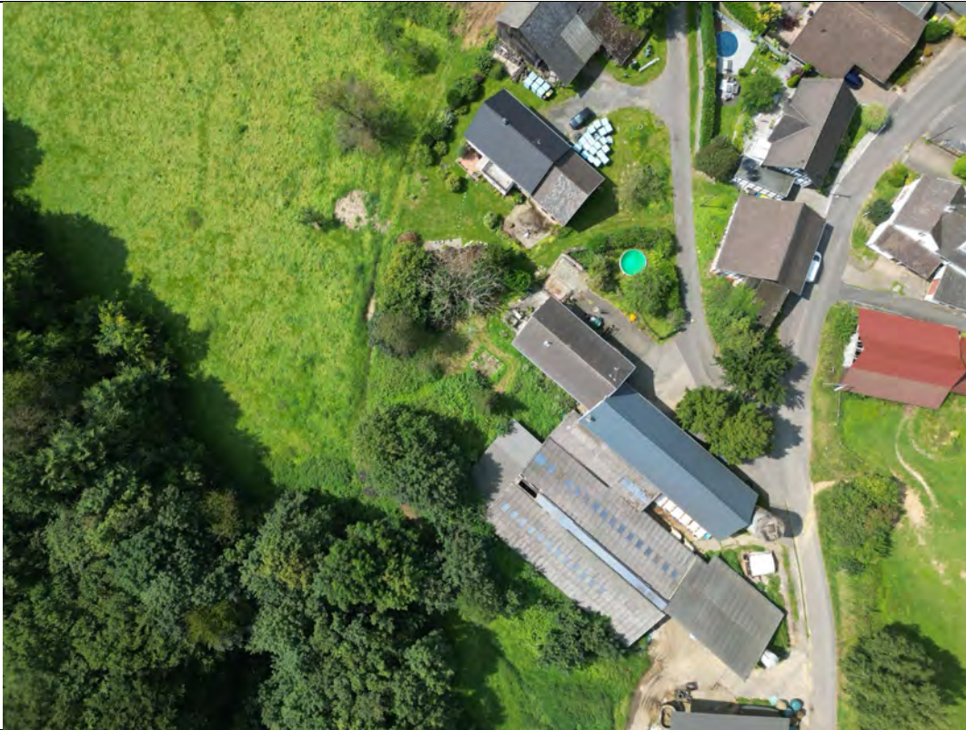
Bild 1 senkrechter Blick auf die Hofstelle mit von unten Kuhstall neu, Kuhstall alt, angebautes Wohnhaus, am oberen Bildrand Altenteilerhaus sowie Scheunengebäude auf Flurstück 147
