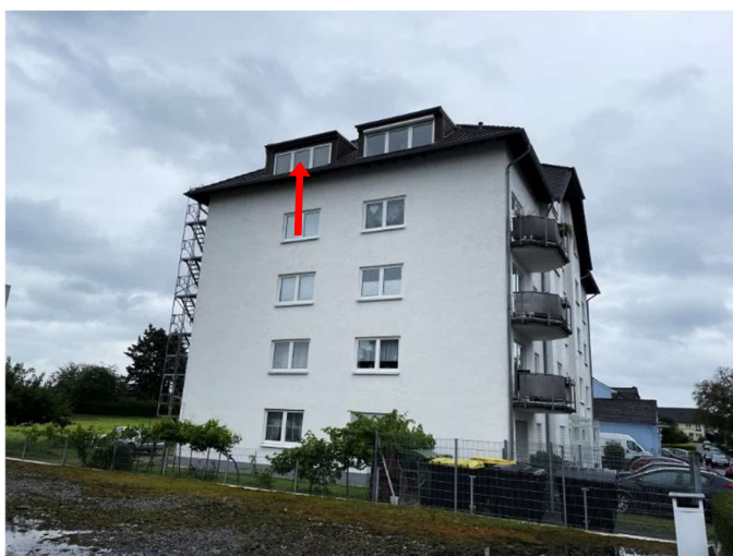
Nordansicht mit Wohnung Nr. 7 im DG und in der Dachspitze
