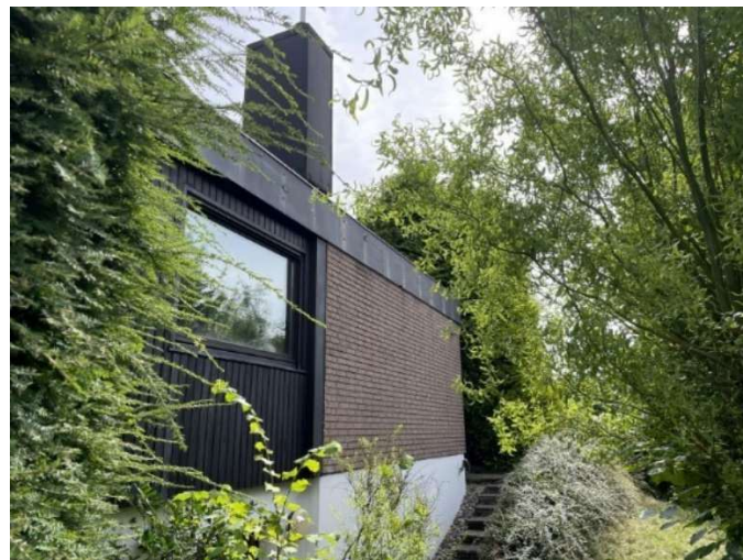
Südwestansicht mit Kellerausgangstreppe
