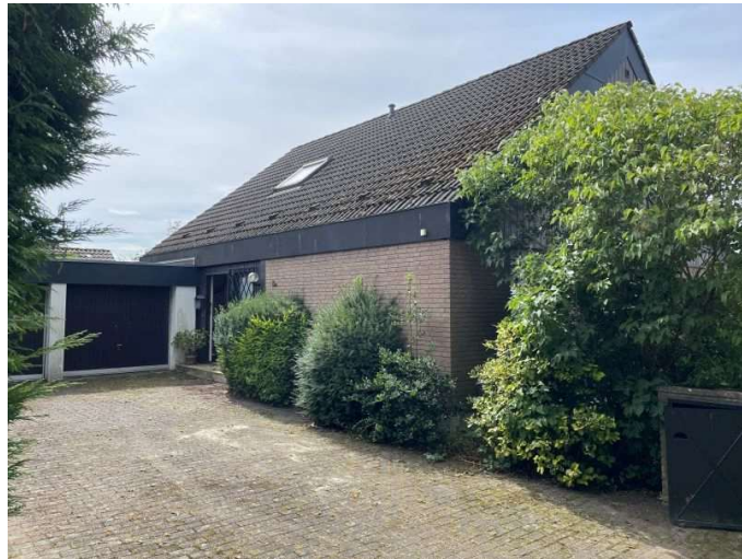
Einfamilienhaus Moltkestraße 2a - Nordansicht
