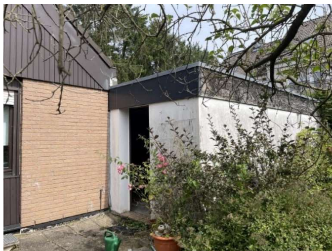
Rückwärtige Ansicht Pkw-Doppelgarage
