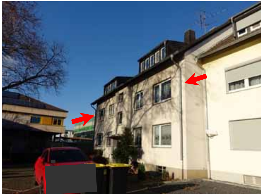
Bogenstraße, Blick Richtung Nordwesten, Sechsfamilienhaus „Bogenstraße 12“
