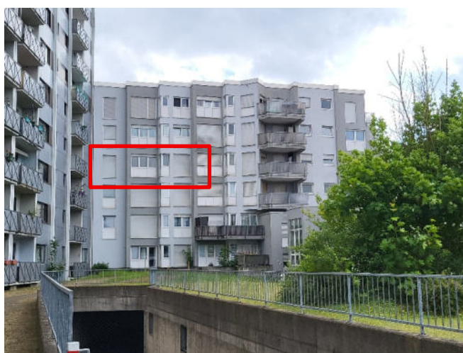
Zufahrt Tiefgarage/ Nordseite Bodelschwinghstr. 3
