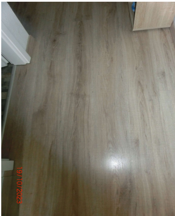
Loggia und Bodenbelag
