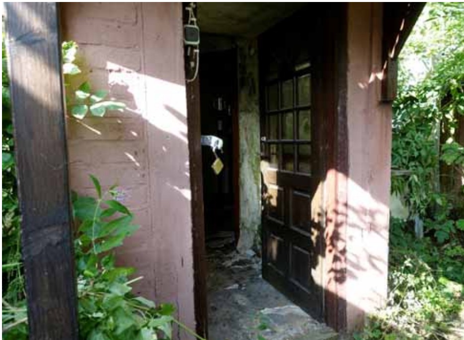
Eingangsbereich des abbruchreifen Hauses „Heidestraße 5a“
