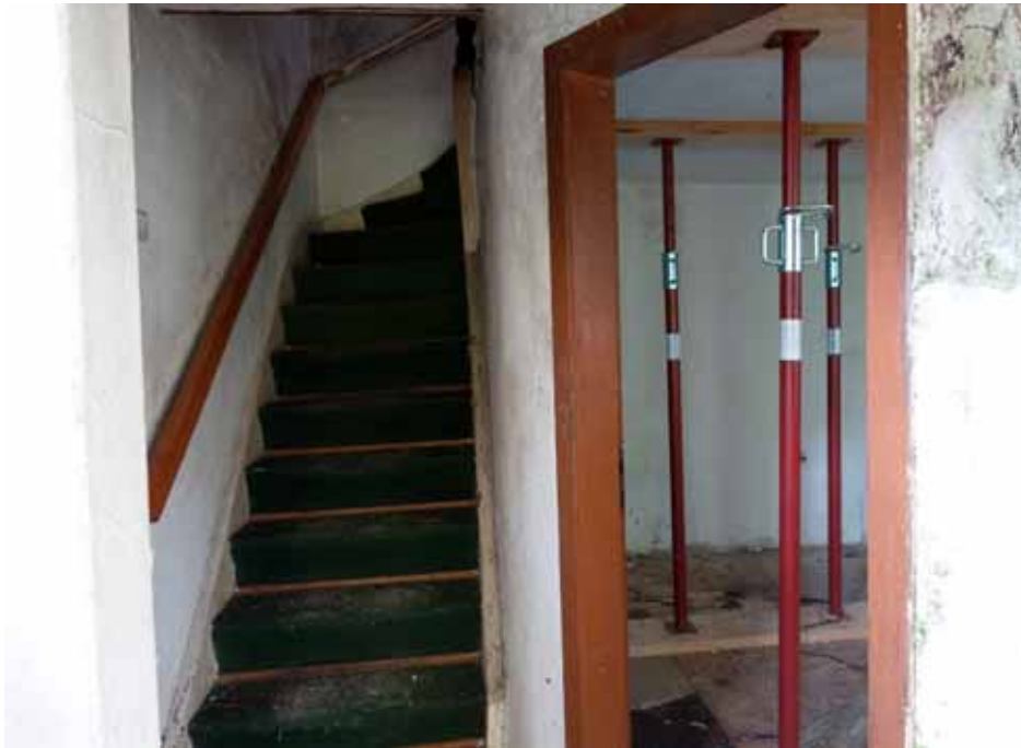
zum Obergeschoss führende Treppe
