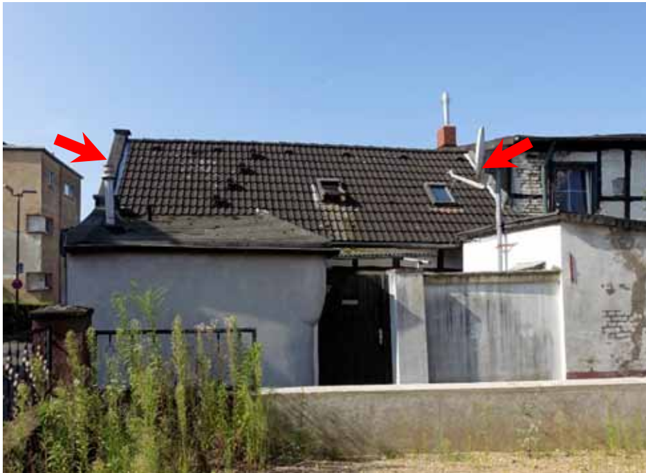
nordöstliche Fassade des Wohnhauses „Heidestraße 5“
