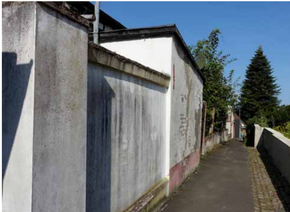
Zuwegung zu den Flurstücken 2926/177, 1385/177 und 1356/177 über den auf dem Nachbargrundstück Flurstück 3313 befindlichen Weg, Blick Richtung Nordwesten
