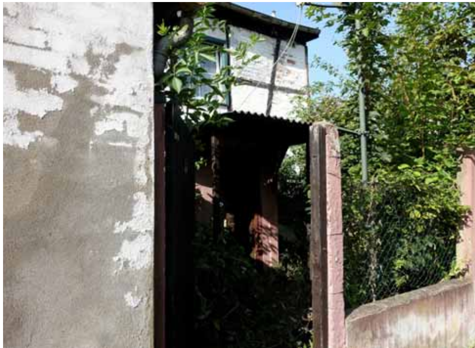
Zuwegung zu den Flurstücken 1385/177 und 1386/177, Wohnhaus „Heidestraße 5a“
