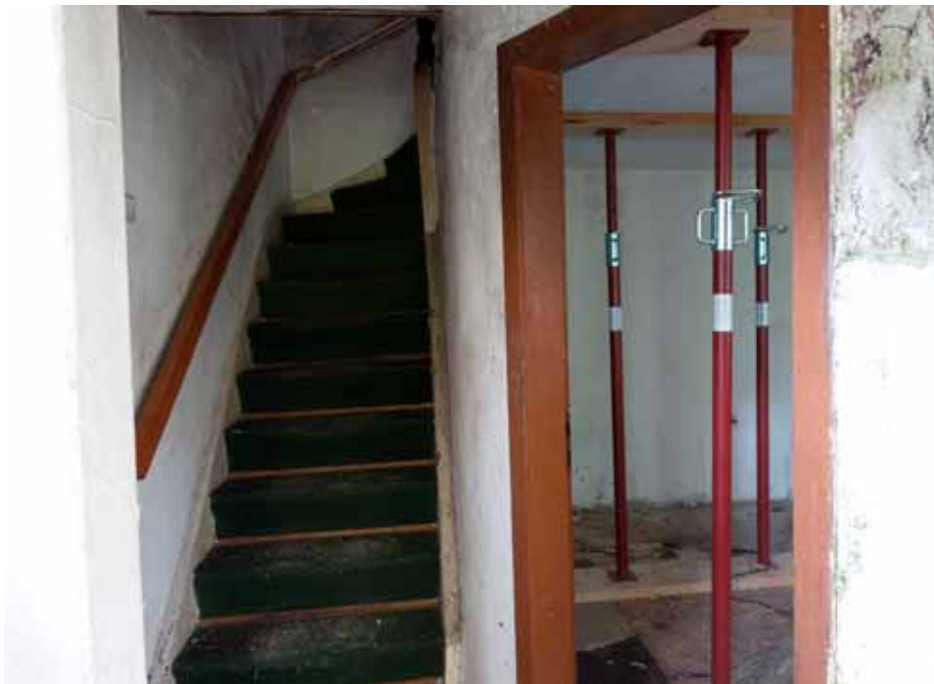
zum Obergeschoss führende Treppe
