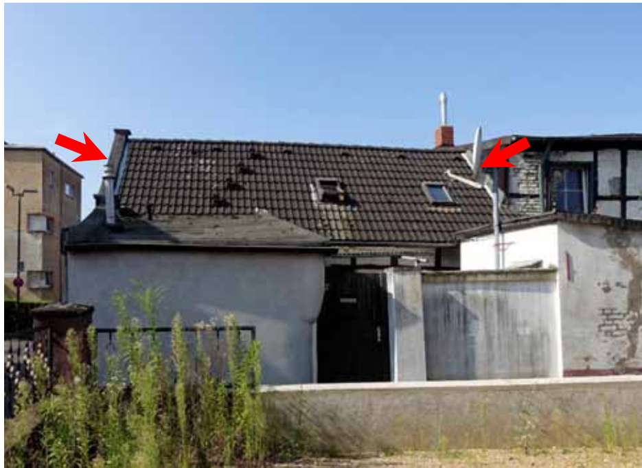
nordöstliche Fassade des Wohnhauses „Heidestraße 5“
