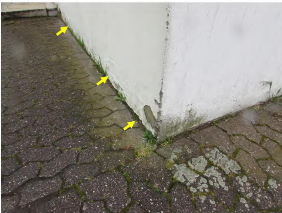
Foto 8: Feuchtigkeit und Abplatzungen im Sockelbereich der Fassade
