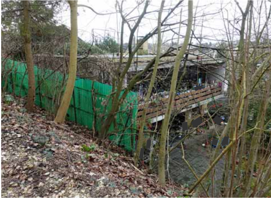
Blick vom südöstlich des Objekts verlaufenden Weg aus Richtung Bewertungsgrundstück
