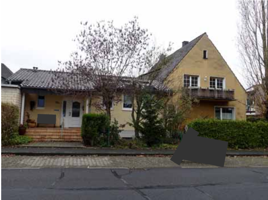
Haupthaus und Anbau II, Straßenansicht
