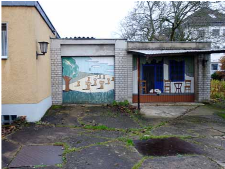
die aneinander angebauten Pkw-Garagen I und II, Front- und Rückansicht
