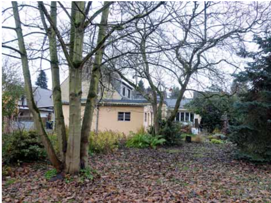
Rückansicht der auf dem Flurstück 3408 befindlichen Gebäude
