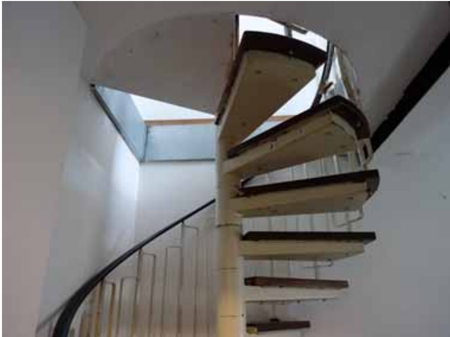
zum Obergeschoss führende Wendeltreppe
