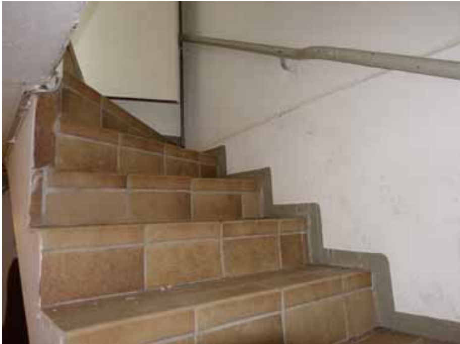
zum Kellergeschoss führende Treppe
