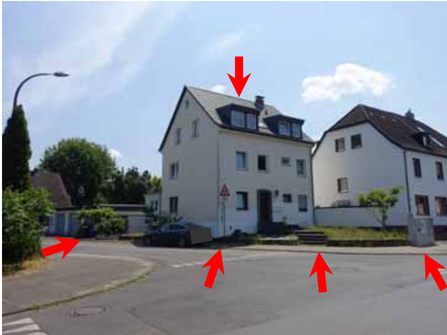
Schulstraße, Blick Richtung Südwesten, Wohnhaus „Schulstraße 29“ (Flurstücke 250, 797 und 249)
