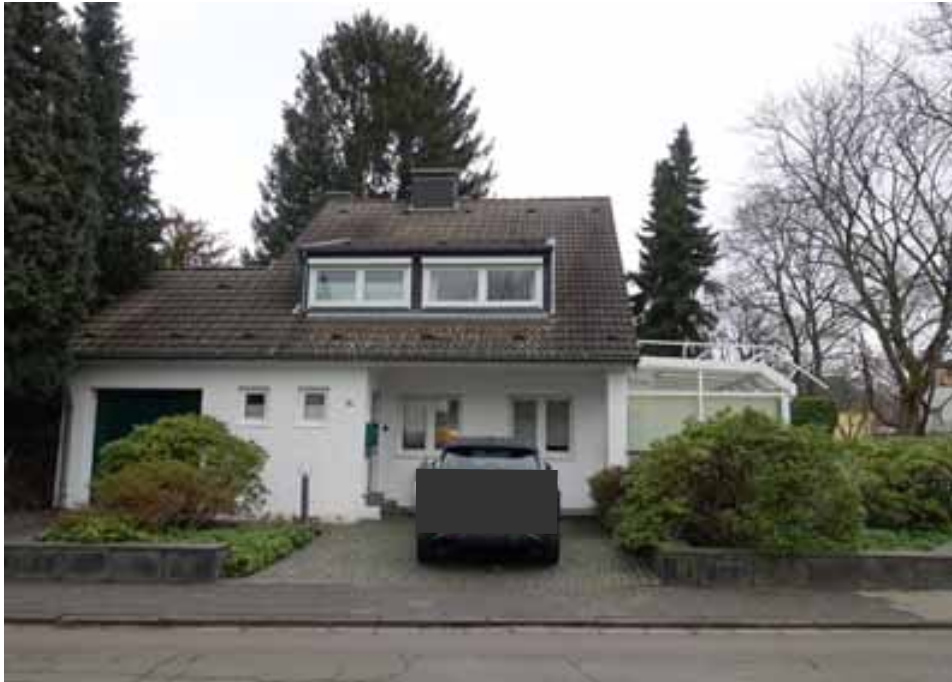
Einfamilienhaus „Pestalozzistraße 14“ mit einer Pkw-Garage
