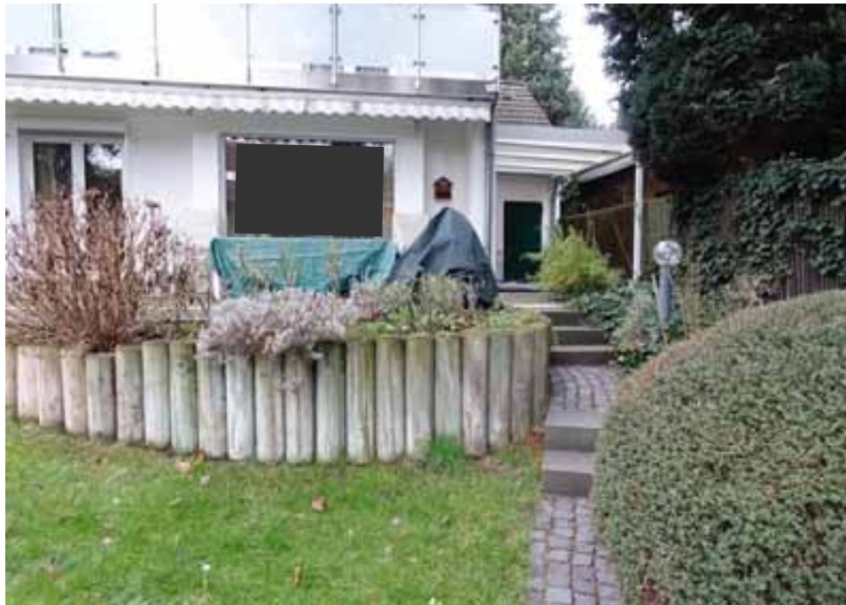
Rückansicht der Gebäude
