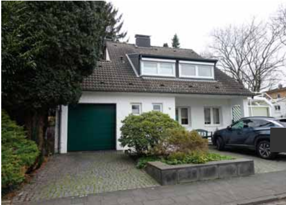
Straßenansicht der Gebäude, Garagenzufahrt
