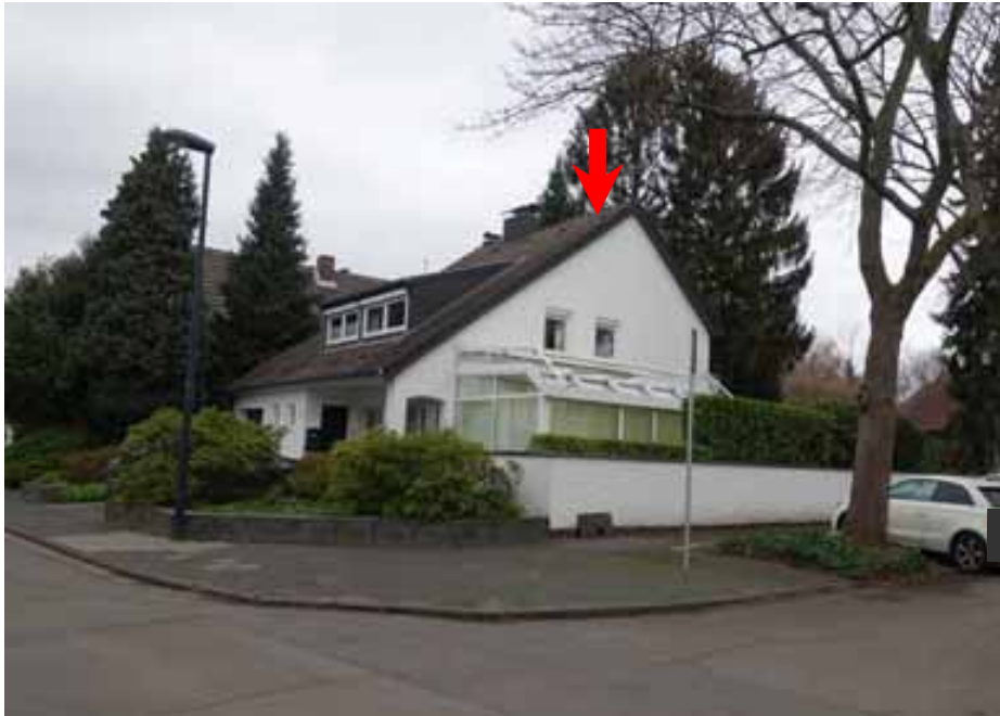
Pestalozzistraße, Blick Richtung Norden, Hausgrundstück „Pestalozzistraße 14“
