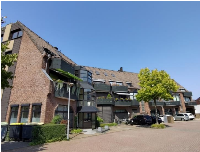
Vorderansicht mit Hauseingangsbereich
