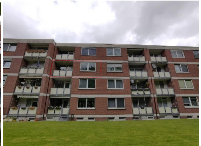
Gartenseitige Ansicht (mit Markierung der Wohnung)
