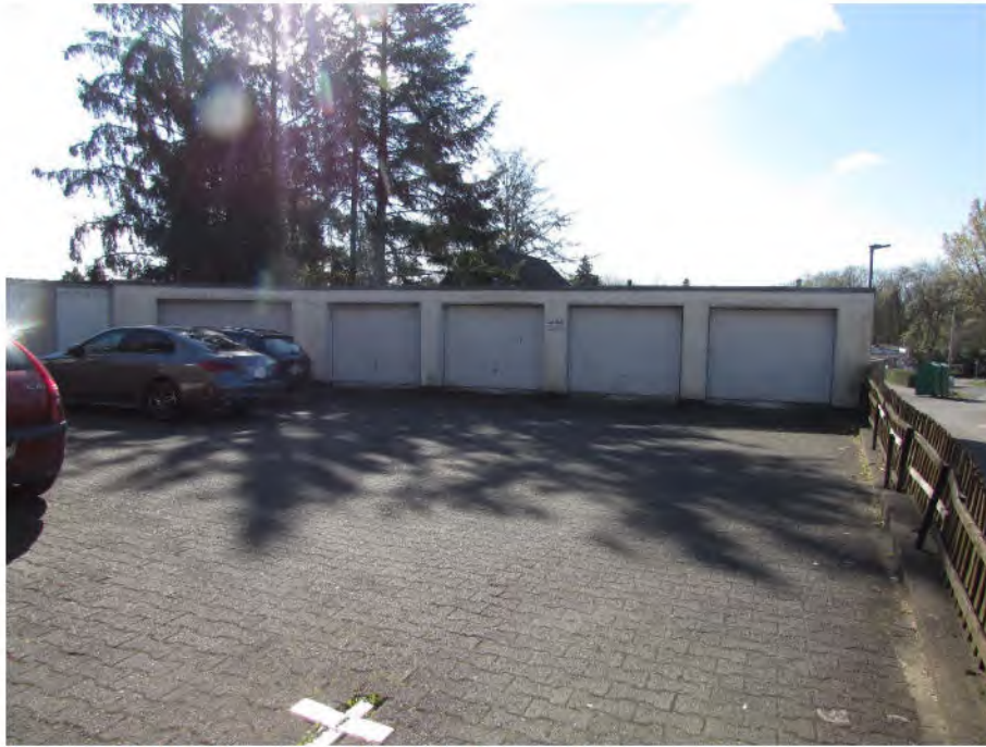
Foto 9: PKW-Garagen, PKW-Außenstellplätze, rückwärtige Hoffläche
