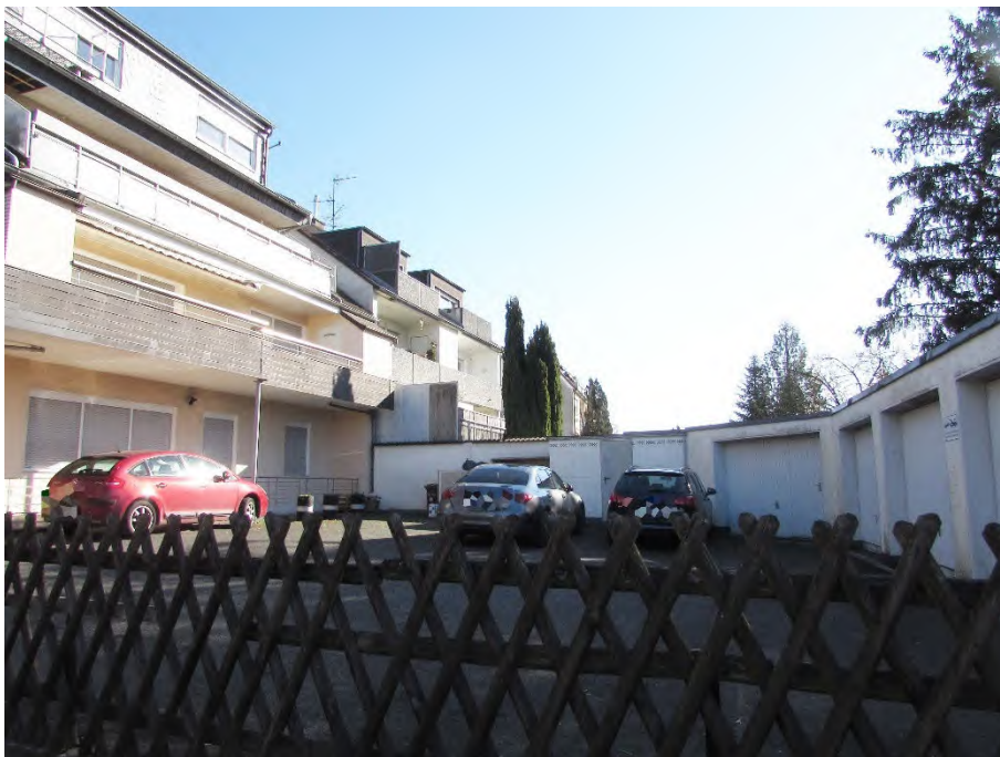
Foto 16: rückwärtige Hoffläche, PKW-Garagen
