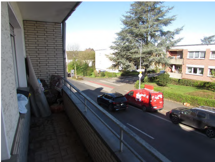
Foto 8: Wohnung 3 (Obergeschoss links), Loggia
