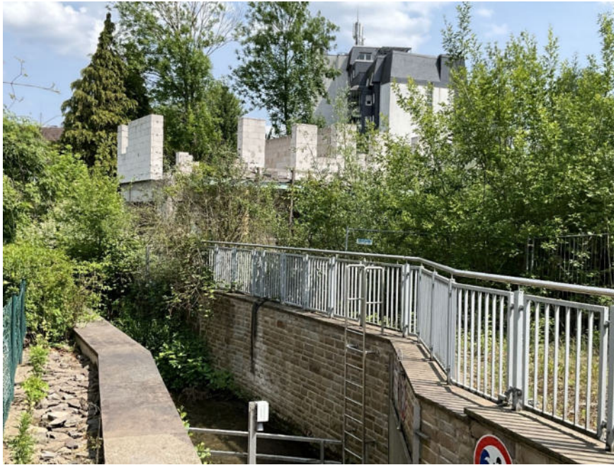
3) Strunder Bach mit Rohbau im Hintergrund
