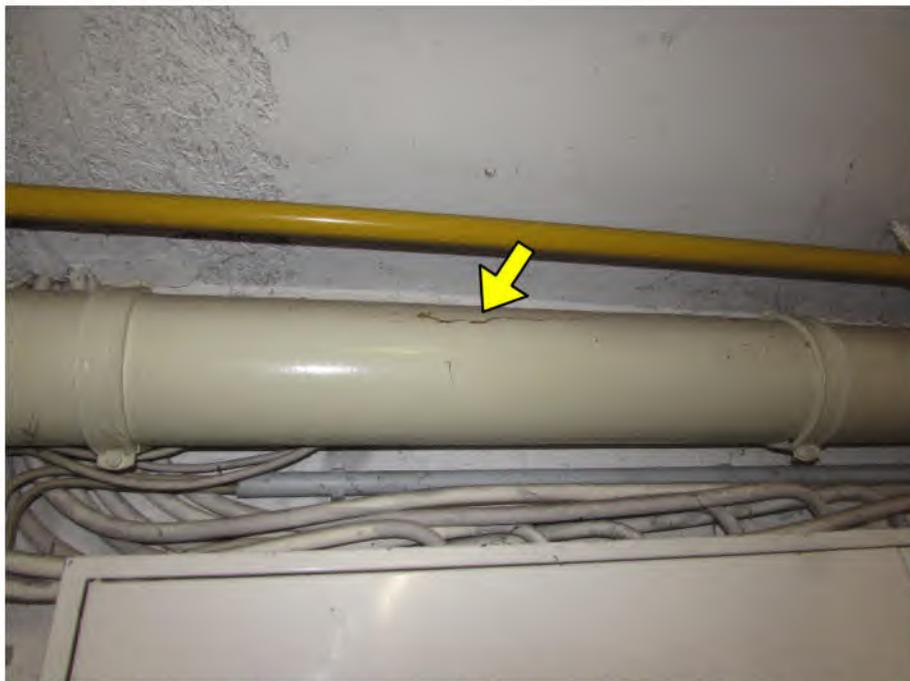
Foto 10: Kellergeschoss, Heizungskeller: gerrissenes/korrodiertes Gussentwässerungsrohr
