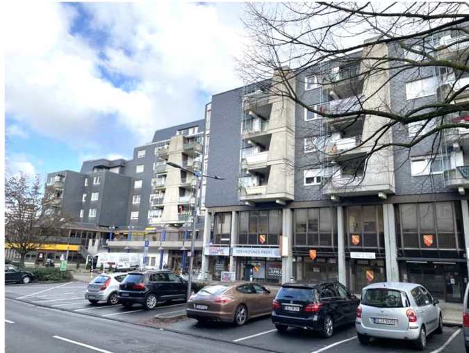
Wohn- und Geschäftshaus Hauptstraße 285 - 297
