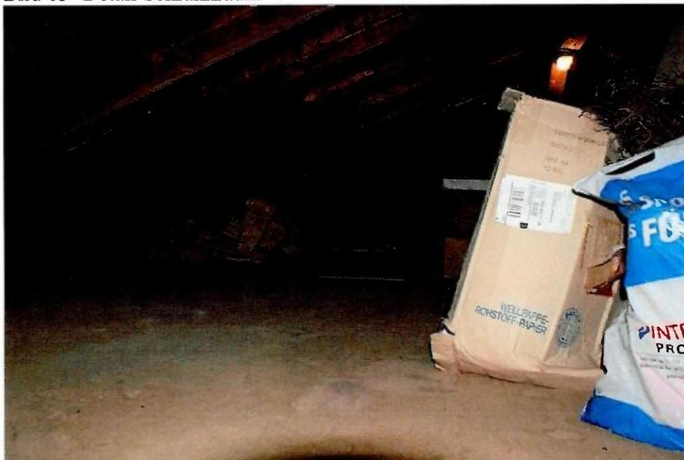
Bild 64 Dachboden zur WE 1, nicht gedämmt
