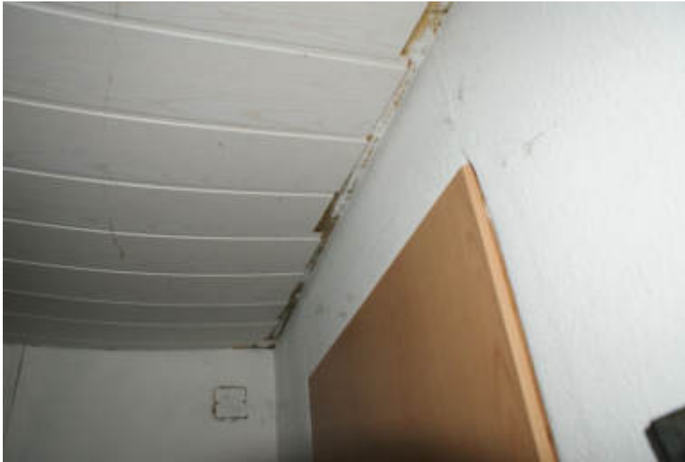
Bild 83 Nicht fachgerechte Decke der <Jagdstube>
