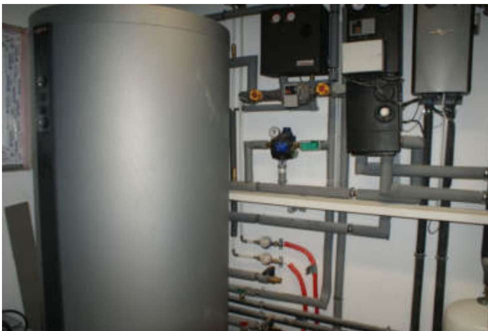
Bild 22 Warmwasserspeicher 1.000 l und Installation
