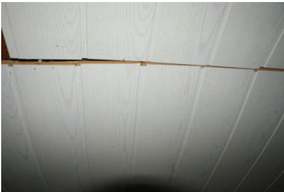
Bild 84 Weitere Schäden an Paneeldecke
