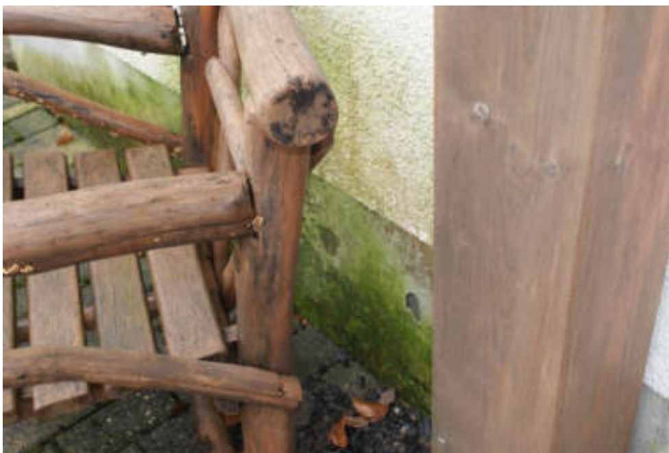
Bild 82 Nässeschäden am Sockel des Nebengebäudes
