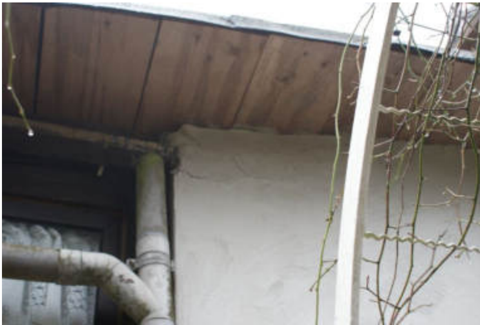
Bild 85 Feuchteschäden und Risse außen
