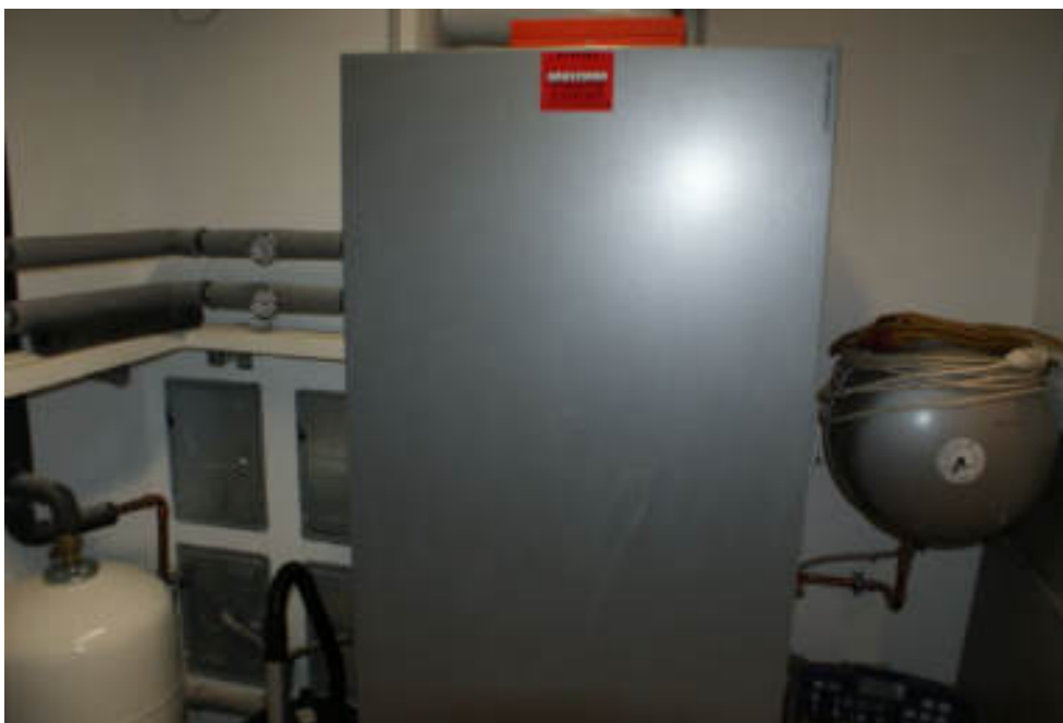
Bild 21 Heizungskeller mit Gaszentralheizung
