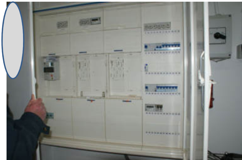
Bild 29 Zählerschrank im KG
