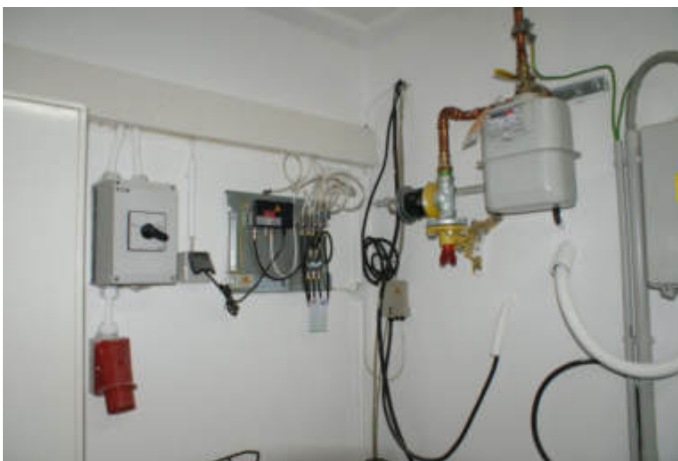
Bild 28 Elektroinstallation mit Trennschalter / Gasuhr
