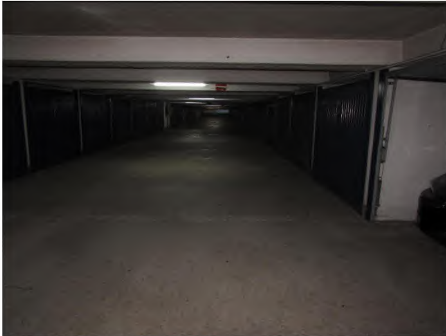
Foto 17: Tiefgarage, obere Ebene
