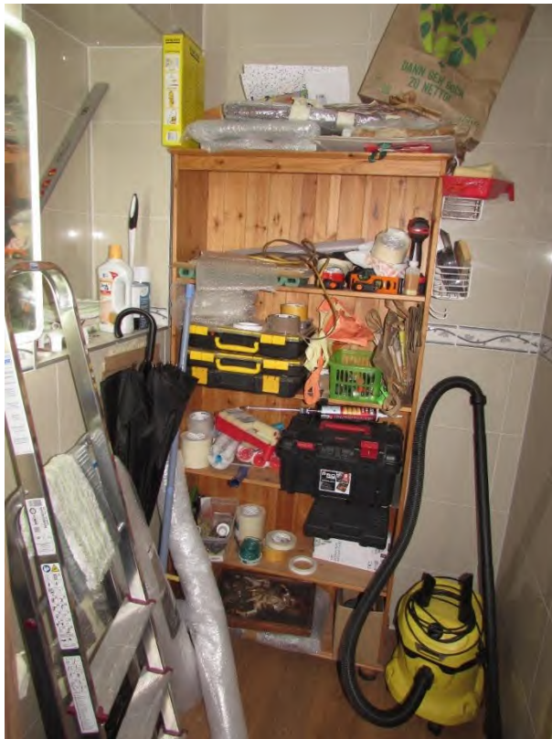
Foto 8: Gäste-WC: fehlende Sanitärobjekte
