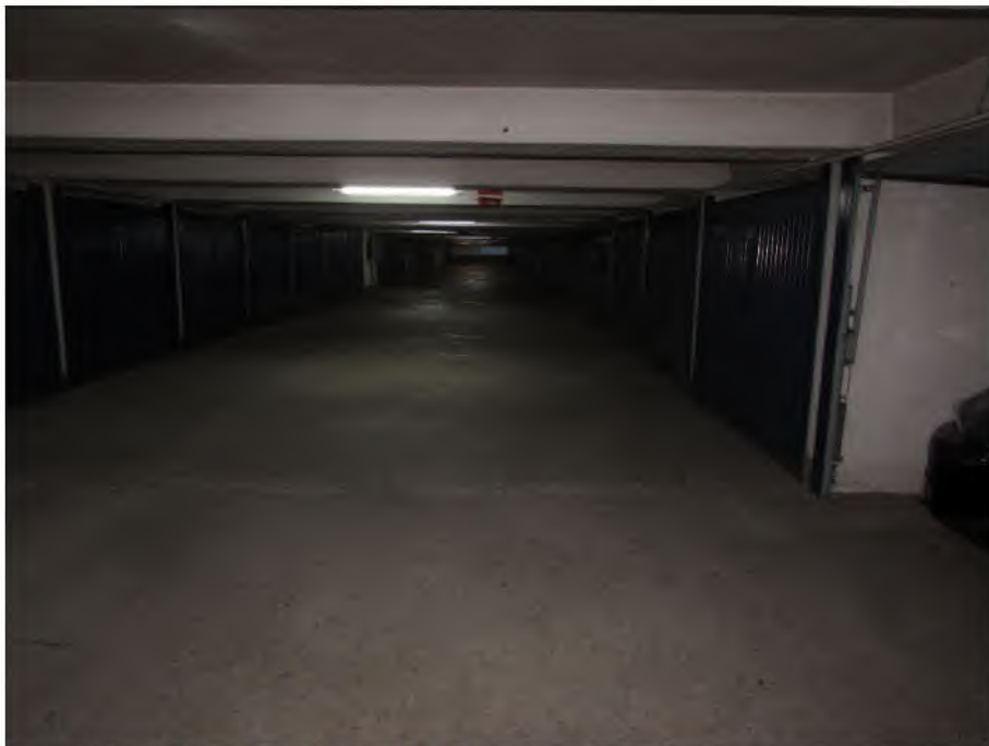
Foto 10: Tiefgarage, obere Ebene
