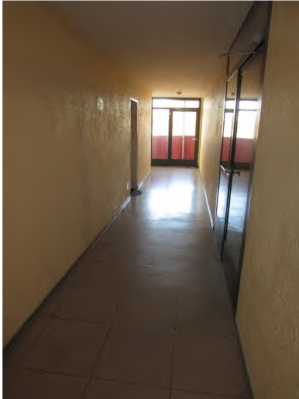
Foto 5: Zugangsflur zu den Wohnungen
