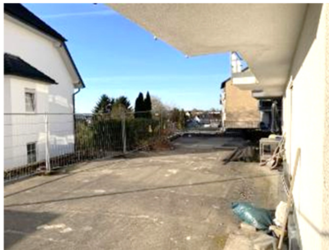
Tiefgaragendach durch den Durchgang erreichbar
