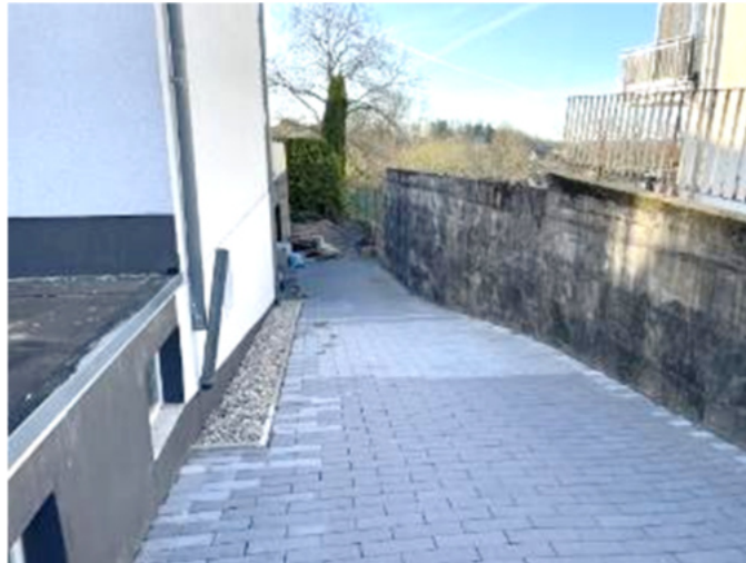
Zufahrt zur Tiefgarage
