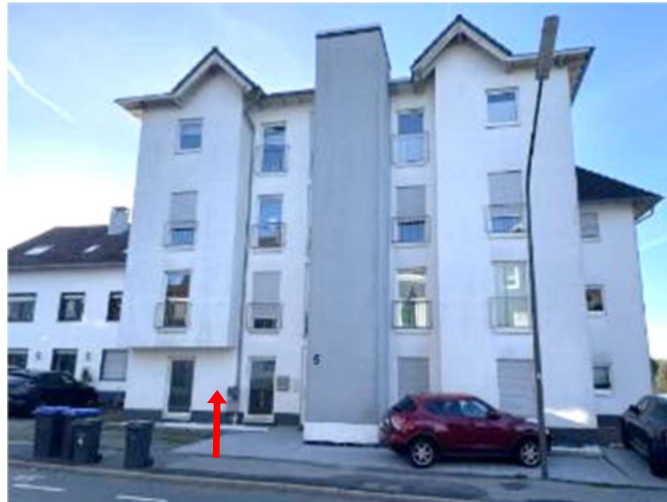
Mehrfamilienhaus Grünestr.5 mit Wohnung Nr. 1 im EG links
