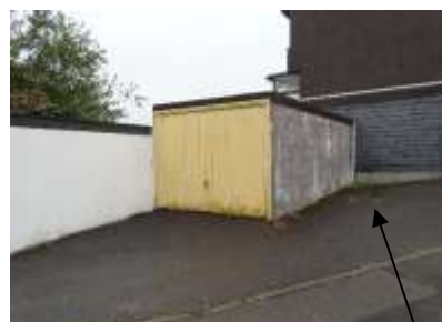
Garage Ansicht von Südwesten mit (B) Wegegrundstück
