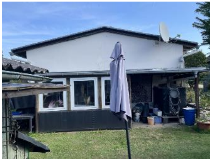
Rückwärtige Ansicht mit Holzschuppen und Holzremise
