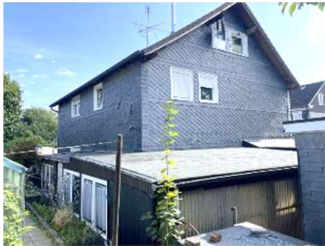
Südwestansicht mit Schuppen- und Carportanbauten
