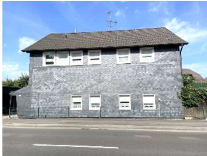
Ansicht von der Bundesstraße 51 (Tente)
