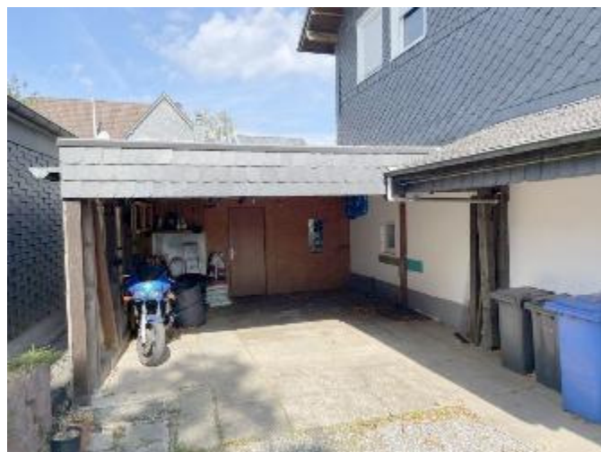
Carportanbau mit Zugang zum Schuppenanbau
