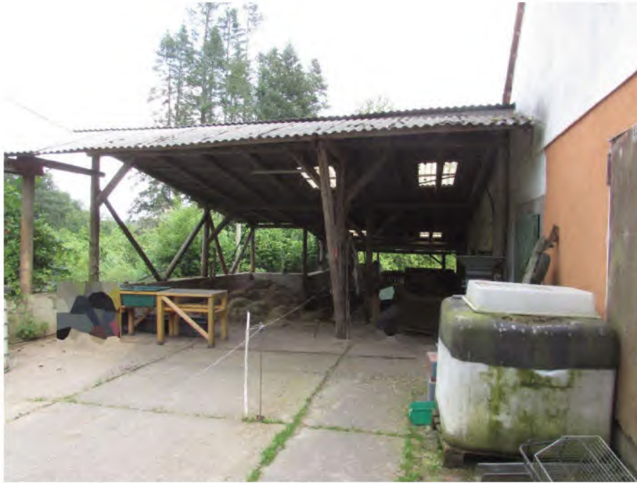
Foto 15: überdachte Dunglagerstätte (mit einem darunter gelegenen Jauchekeller)
