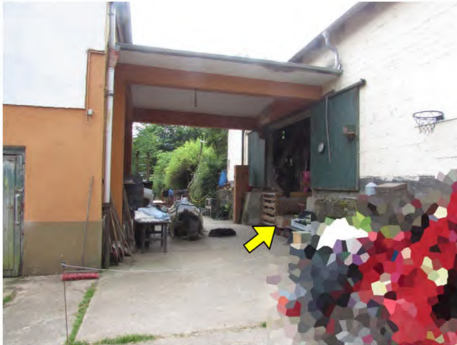
Foto 23: Scheunengebäude, Zugang (mit der Hofüberdachung davor)
