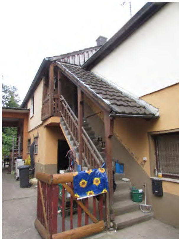
Foto 2: Wohn-/Stallgebäude, Außentreppe zur Wohnung im Dachgeschoss
