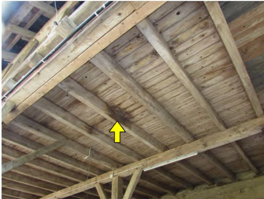
Foto 13: Remise: Feuchtigkeitsfleck im Deckenbereich
