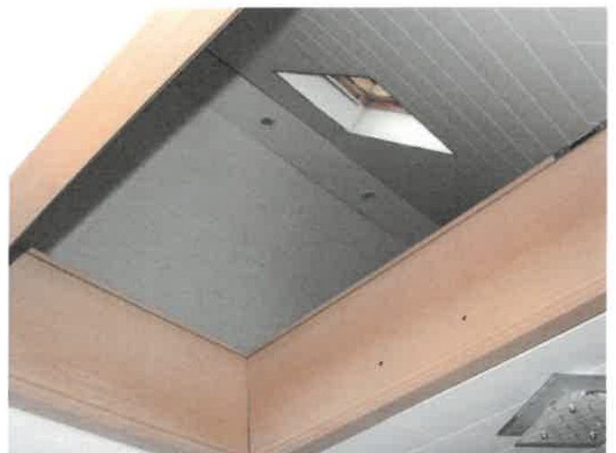
Spitzboden teilausgebaut - bedingt nutzbar
