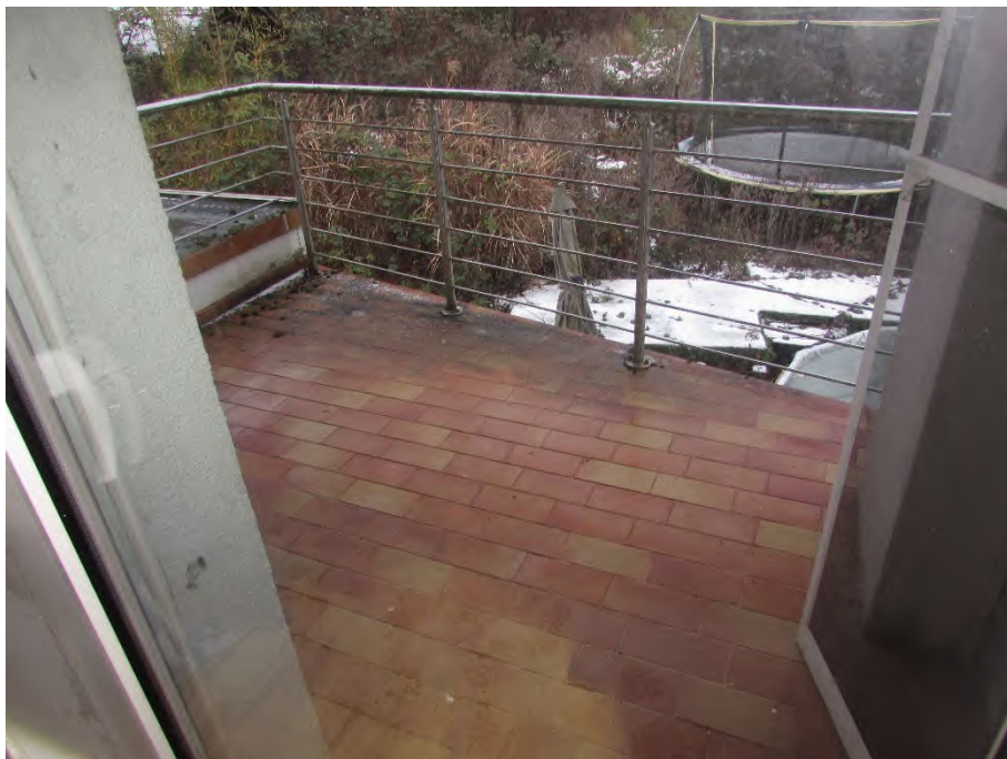
Foto 6: Erdgeschoss Anbau (Whg 1), Dachterrasse/Balkon
