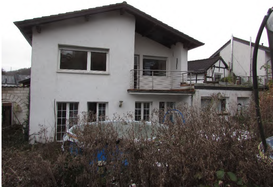
Foto 5: Wohnhaus-Anbau und PKW-Garage, rückwärtige Ansicht
