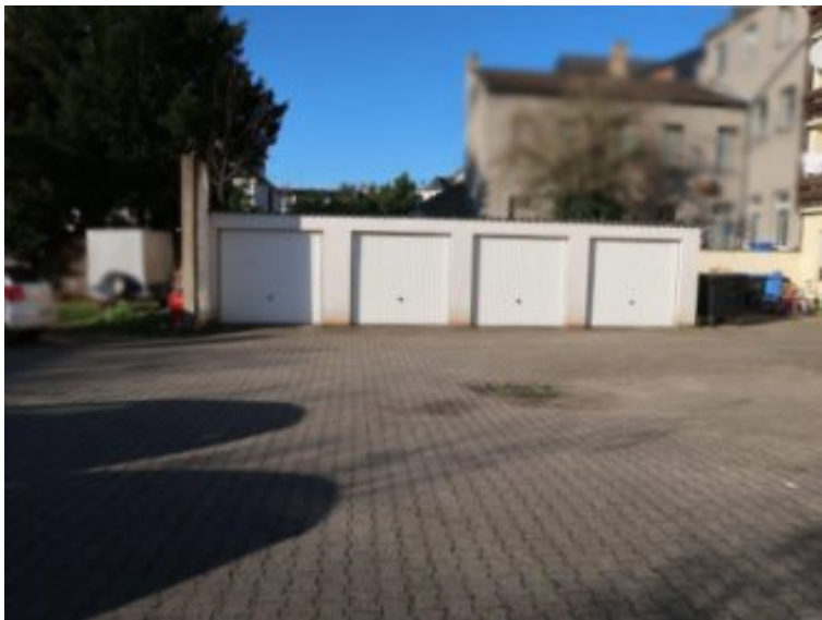
Bild 5 Außenansicht Hinterhof mit Garagen
