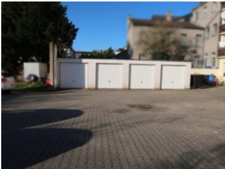
Bild 5 Außenansicht Hinterhof mit Garagen
